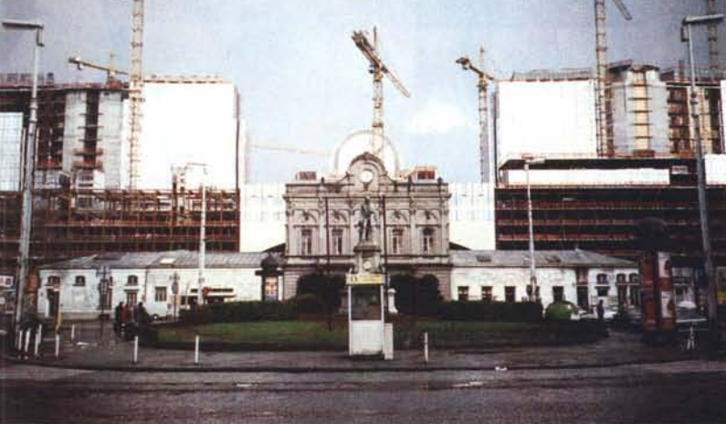
I lavori per la costruzione del Leopold Centre, nuova sede degli uffici della UE a Bruxelles.
