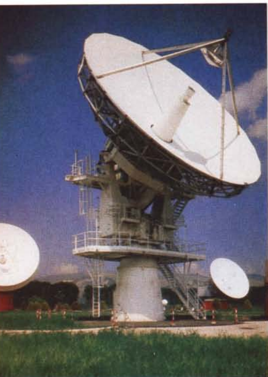
Un'antenna del centro di Telespazio nella Conca del Fucino. Le comunicazioni satellitari si integreranno con quelle via cavo per costruire le autostrade dell'informazione.
