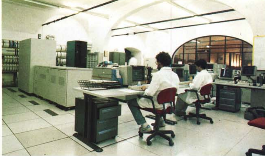
La sala macchine del CED del Comune di Padova. Le moderne apparecchiature si inseriscono perfettamente negli antichi locali dando ugualmente una dimensione umana all'ambiente.
