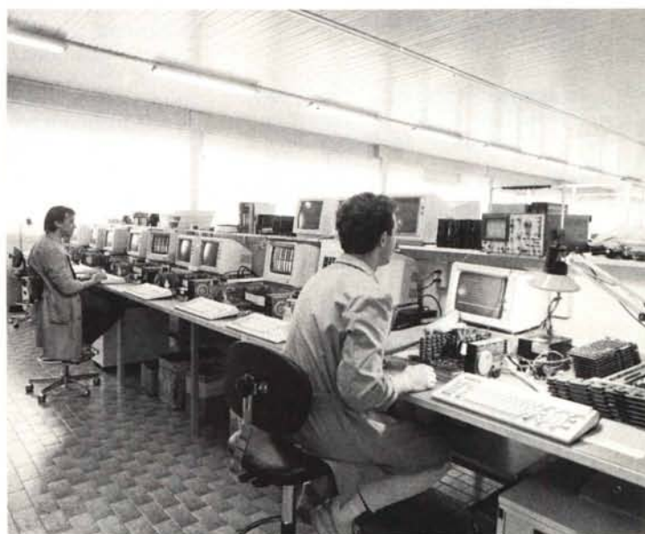
Una fase del collaudo delle schede prima del montaggio dei computers. Sotto, una fase della realizzazione del master.
