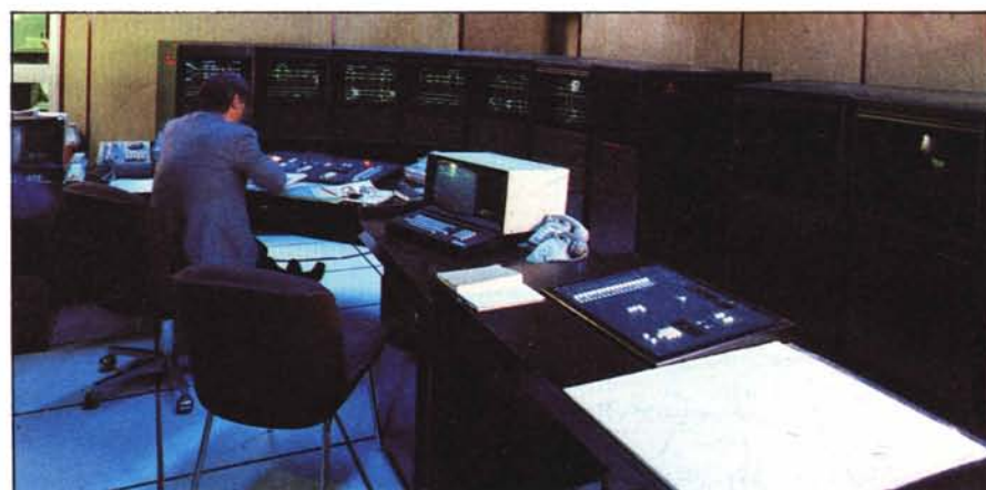
Un'immagine della sala operativa. La visualizzazione della linea avviene tramite sei monitor fissi (ciascuno dei quali mostra sempre una stessa porzione) più due, in basso, per lo zoom sui vari nodi; altri tre monitor sono a disposizione di un eventuale operatore ausiliario, per la manovra di carrelli.
